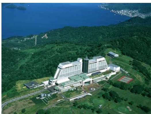
ザ・ウィンザーホテル洞爺の外観
