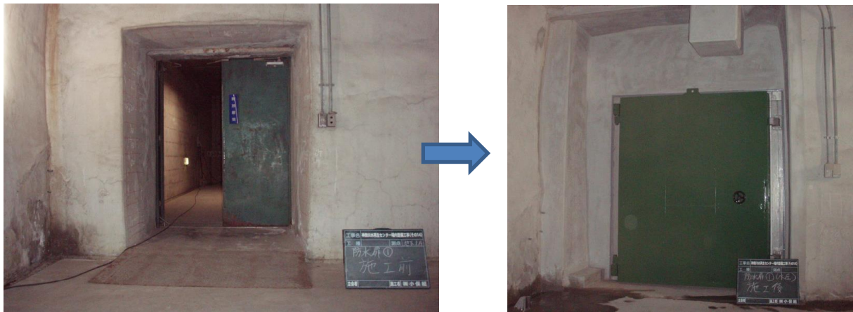
図 3-3 防水扉への更新
