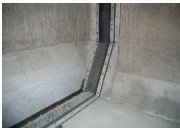
図 1-4 後付け式伸縮可とう継手の設置
