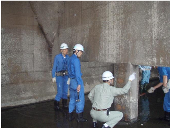
図 2-5 局職員等による目視・打音
