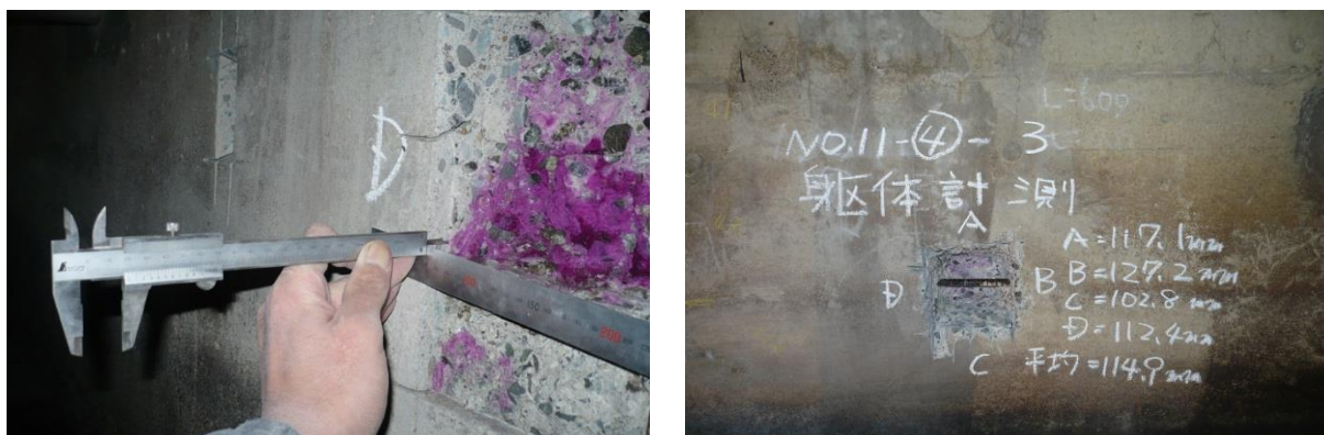
図 2-12 中性化深さの測定
