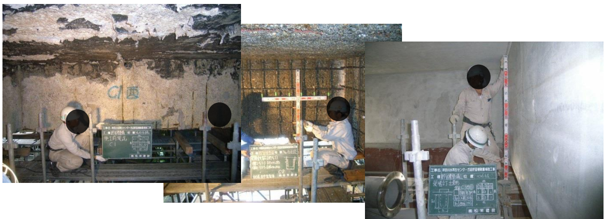
図 2-11 耐震補強と合わせた防食事例
