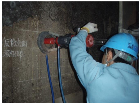
図 2-6 専門業者によるコア抜き
