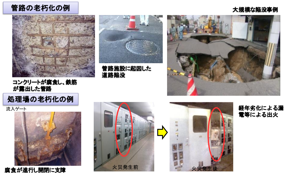
図 1-3 下水道施設の老朽化に起因した事故(国土交通省資料)
