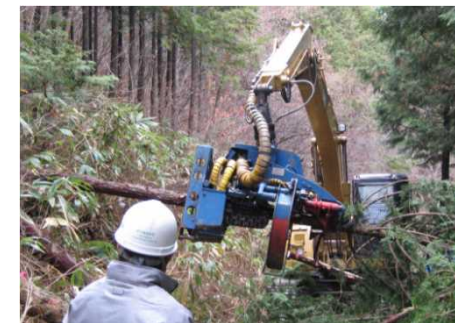
同協同組合による伐採作業の様子
