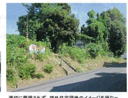
適切に管理されず、郊外住宅団地のイメージを損なっている
