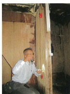
下げ振りによる柱の傾斜計測
