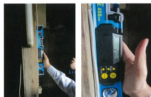
デジタル水平器による柱の傾斜測定
