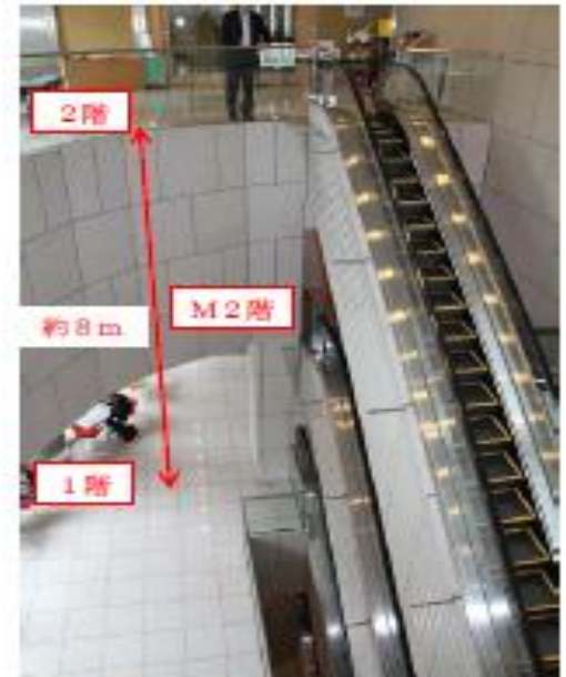
写真1. 事故が発生した吹抜け部分
