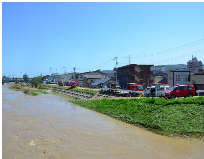
久慈川右岸内水排水作業
