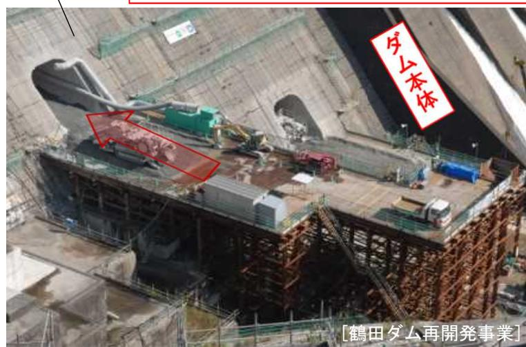
[鶴田ダム再開発事業] ダムの安全性を確認しながら削孔
