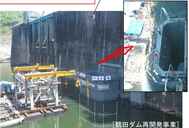
[鶴田ダム再開発事業] 仮締切により水深約30mで作業
