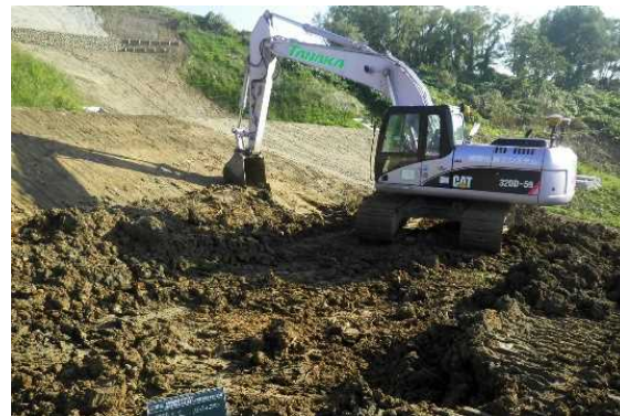
○ ICTバックホウによる法面整形
