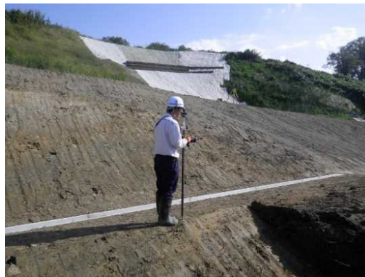
○ 出来形確認の状況
