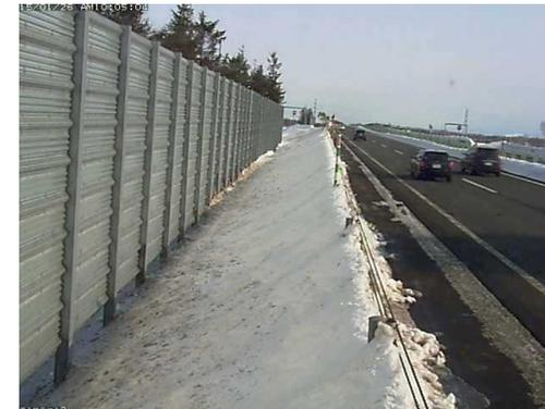
大型車のドライバーの目線の高さをカバーする防雪柵を整備
