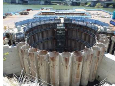
水深約30mの トンネル洪水吐呑口部工事
