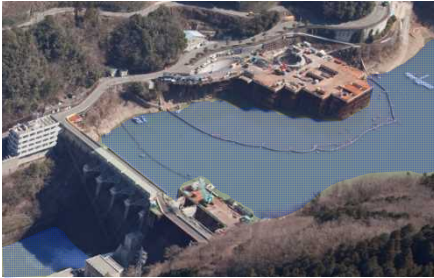
ダムを運用しながら、施設を改良
