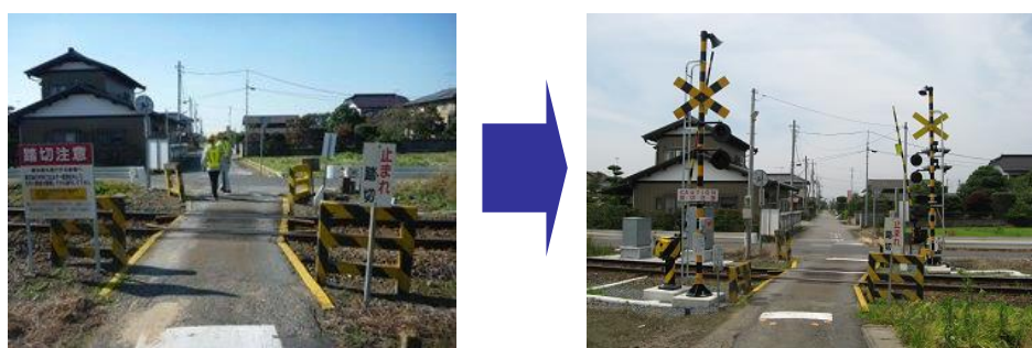
図20：踏切遮断機・警報機の整備
