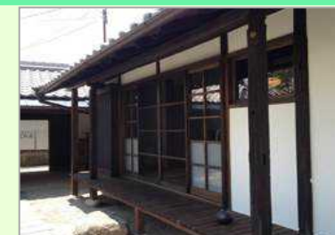
【古民家を宿泊施設に改装】
