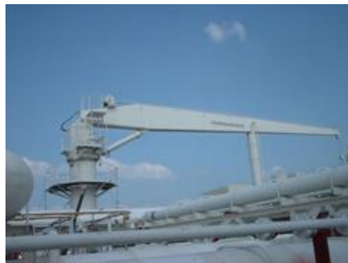
(デッキクレーン)
