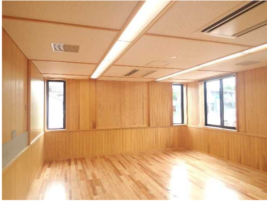
木造化 <西都児湯森林管理署 会議棟(CLTパネル工法※)>
