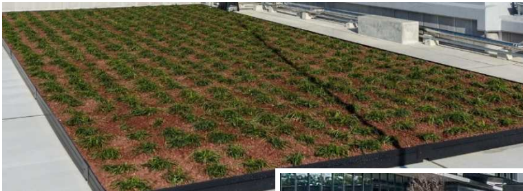
屋上緑化 <土浦労働総合庁舎>
