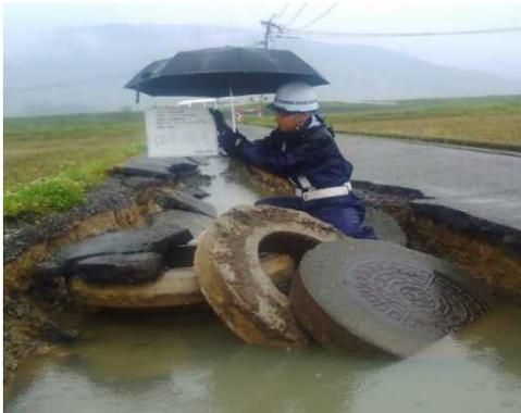
液状化による下水管の被害状況
