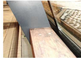
写真 カーテンウォールのペアガラス・シリコンゴム及び集成材
