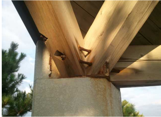
写真 塩害による接合金物の錆の例
