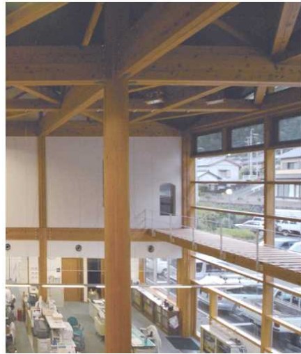
写真 吹き抜け中間に設けられたキャットウォークの例 4)
