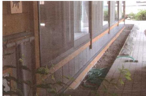
図 バリアフリー対応の土台まわり 4) (シロアリが隙間から浸入しやすい。)
