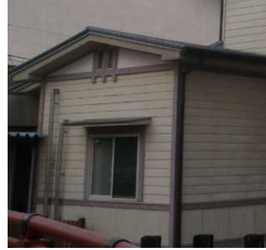
写真 窓の上部に雨掛かりを防ぐための庇を設置している例 21)
