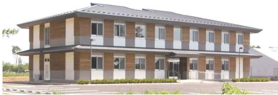
写真 1階にも庇を設置した2段庇の例 18)
