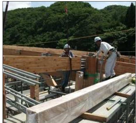
写真 多湿空間の柱・梁接合の例
