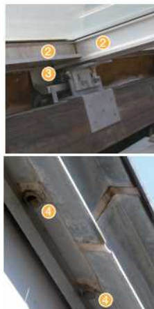
図 天窗の結露を排出する機構の例 4)
