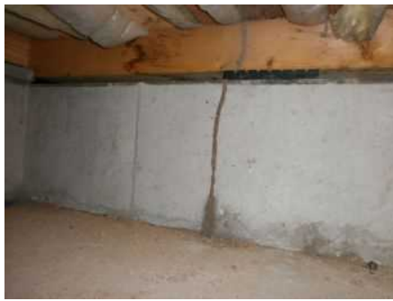
写真 基礎、土台部分の蟻害の例 (基礎から土台にかけての蟻道が見られる。)
