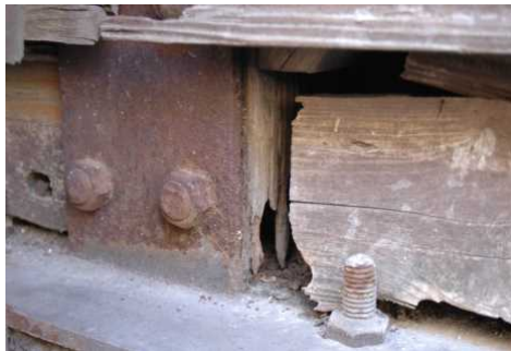
写真 火山灰による接合金物の発錆の例
