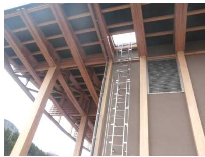
写真 ソーラーパネル点検用はしごの例 19)
