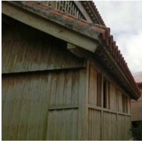
写真 外装材表面における藻の発生例 (外壁の木材は防腐処理をしているが、防藻剤は用いられていないものと思われる。)
