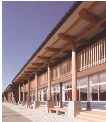
写真 軒樋を設置しない対策の例 4)
