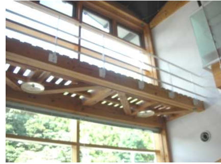
写真 吹き抜け中間に設けられたキャットウォークの例 4)
