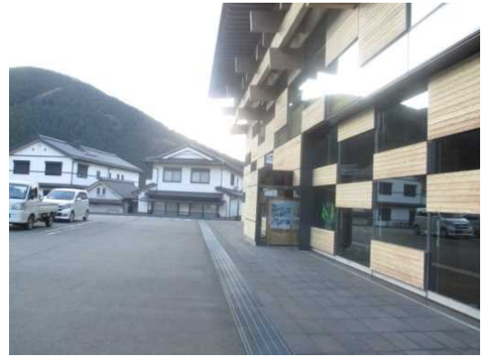
写真 軒樋を設置しない対策の例 17)
