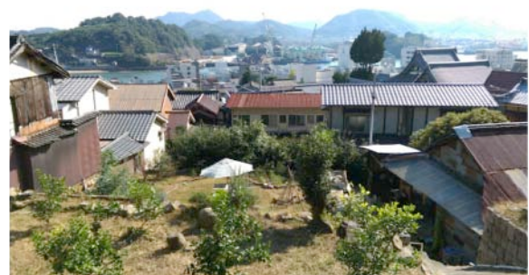
図2. 一度空き地になると建物は建てられない
