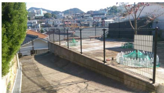
図9. 生活道路を拡幅する形で整備
