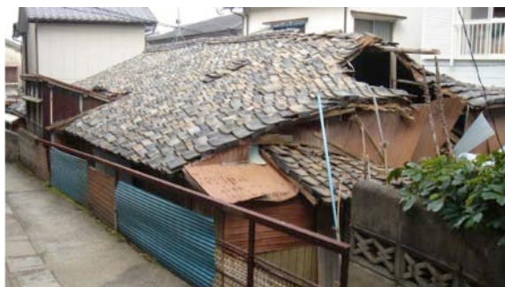
図 3. 屋根が崩壊した空き家（長崎市 HP より）
