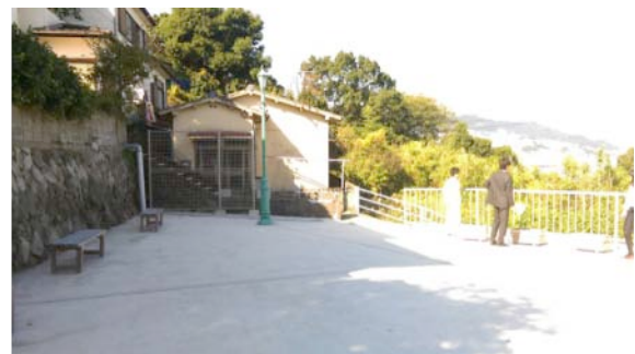
図 6. 間伐材を使ったベンチと設置された電灯
