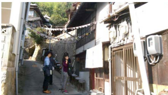
図7. 移住者による空き家を改修したパン屋
