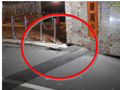
【市道の陥没発生直後の状況】
