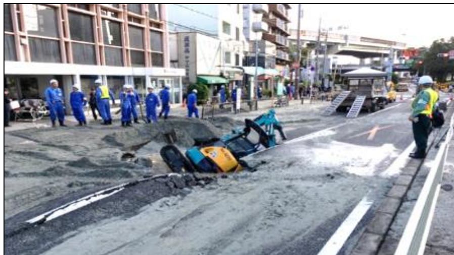
腐食に伴う水道管破裂による路面陥没（長さ10m、幅5m、深さ3.0m）
