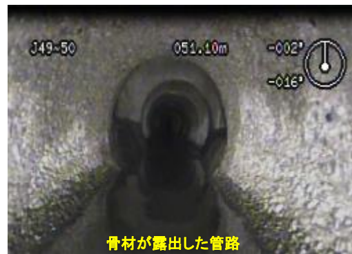
● 管路の老朽化の例
