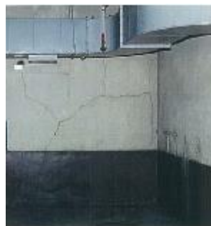
ひび割れ調査
