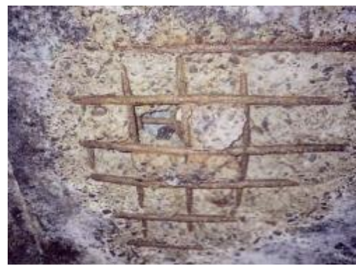
● 管路の腐食の例
