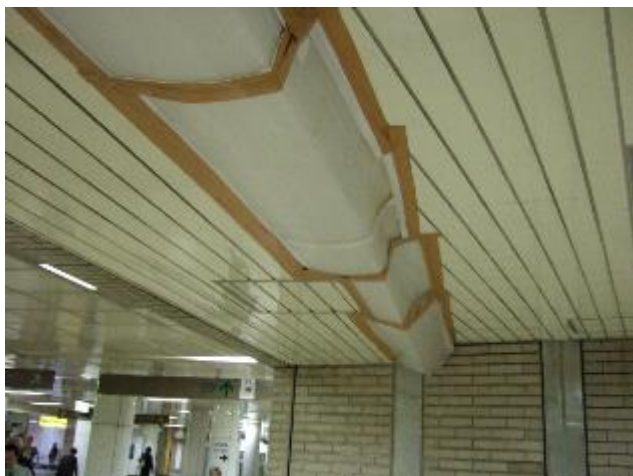
地下通路の漏水の様子
