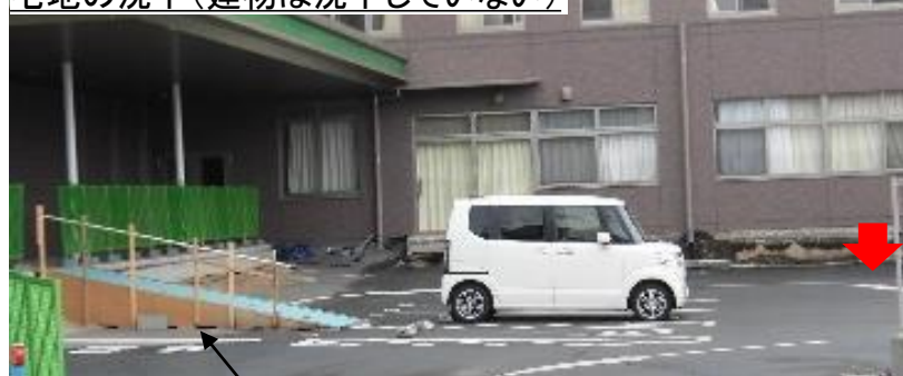
地震後に斜路を応急復旧
