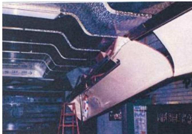
吊り天井の脱落被害の様子
