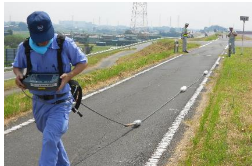
牽引式電気探査の実施状況
