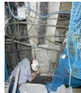
天井点検調査
