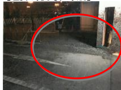
【埋戻し完了後の状況】
