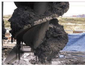
(a) 廃棄物層掘削時
