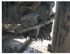
(b) 床付け時（粘土層1m）
