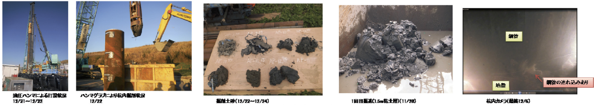
付録図-2.7 試験杭4の施工概況
