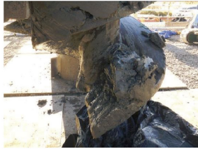
(c) 1回目掘進時（粘土層2m）
