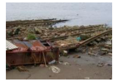
石巻地区の被災状況 (湾曲し修復困難な船台)
