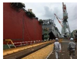
JMU 呉事業所の建造現場
