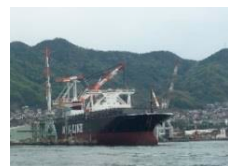
14,000TEU コンテナ船 (建造中)
