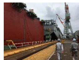
JMU 呉事業所の建造現場
