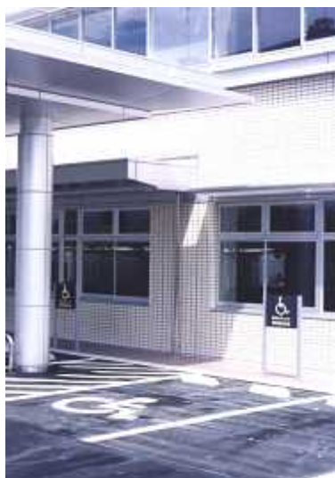
車いす利用者用 駐車場の整備
