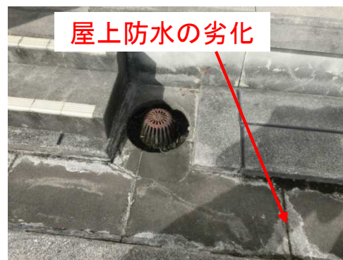
屋上(左)、天井(右)：屋上防水の劣化・剥離により、屋内天井に漏水が発生している
