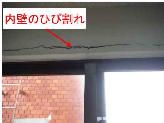
内壁：ひび割れが発生している
