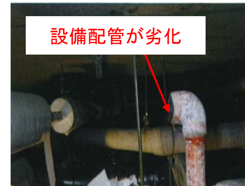
機械設備：天井裏内の設備配管に錆等の劣化が見られる
