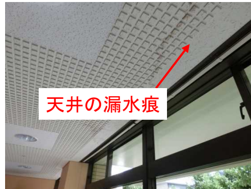
屋上(左)、天井(右)：屋上防水の劣化・剥離により、屋内天井に漏水が発生している
