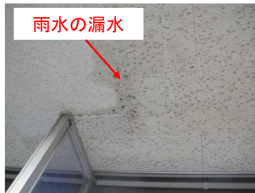
天井：雨水の漏水が発生している
