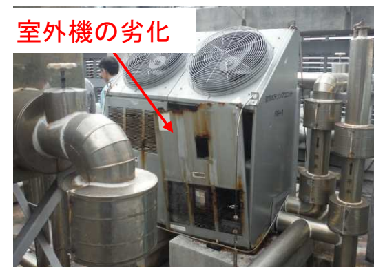
設備：室外機の劣化が見られる
