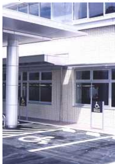
車いす使用者用 駐車場の整備
