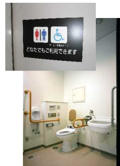
多機能トイレの整備
