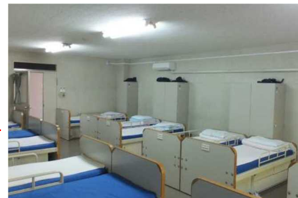
既存宿泊施設(寝室)の状況
