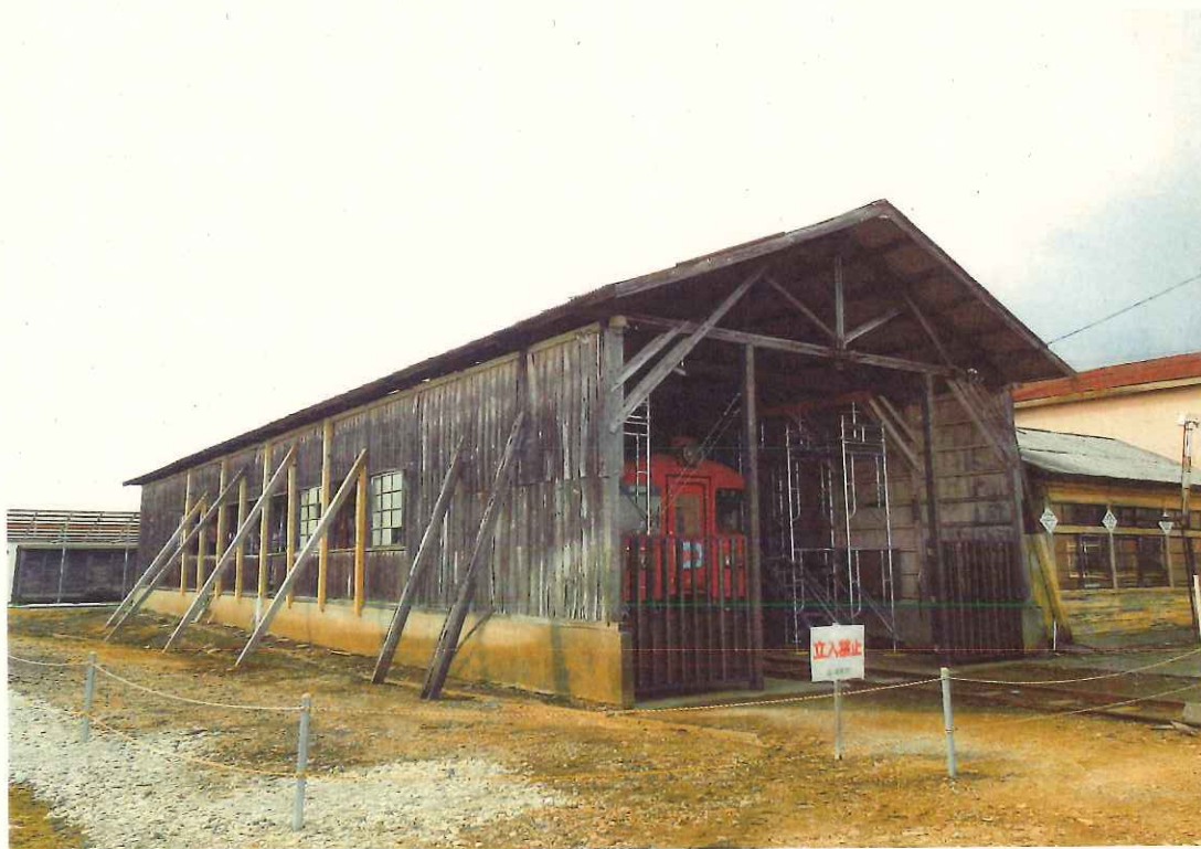
文化財ドクター助言による応急復旧 2011 年（屋根の足場による仮受けなどの緊急対応）
