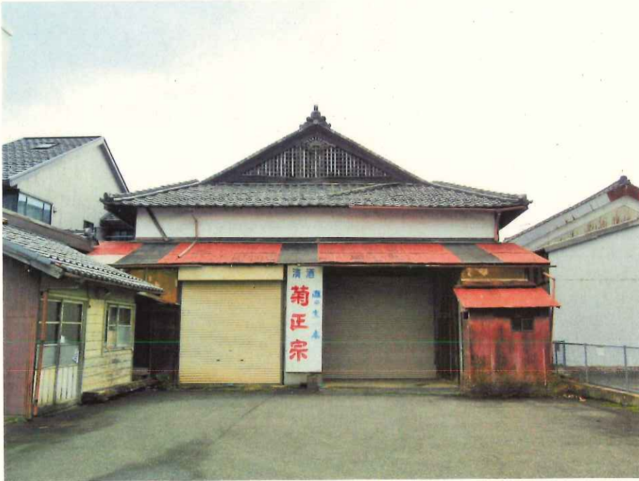
移築前の外観
