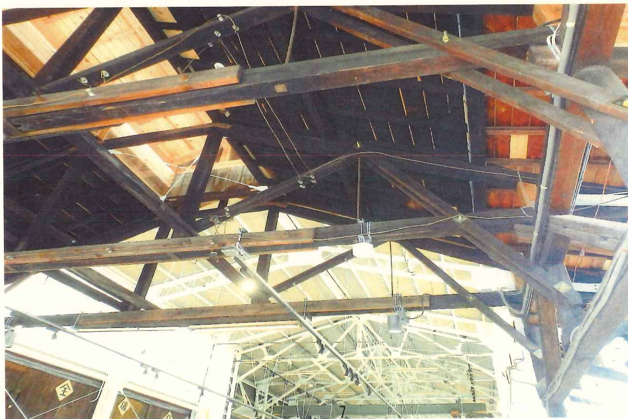
保存活用された機関車庫 (大正 9 年/木造トラス構造)
