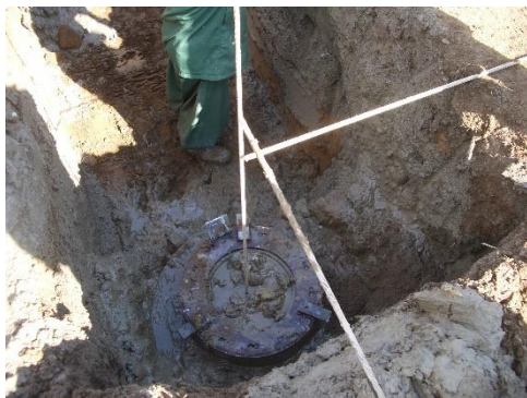
杭施工後確認
