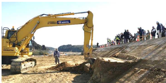
丁張り不要の圧倒的な施工効率を体感
