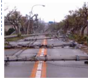
<電柱の倒壊による道路閉塞>
