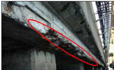
<首都高速 東品川栈橋>
