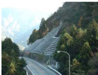
<のり面防災対策>
