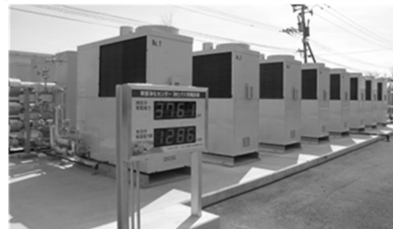
熊本市東部浄化センター バイオガス発電施設
