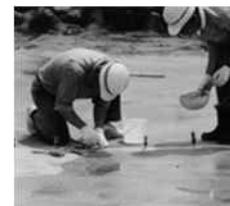
クラック補修状況（注入工）
