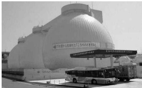
バイオガスを精製して自動車燃料として供給
