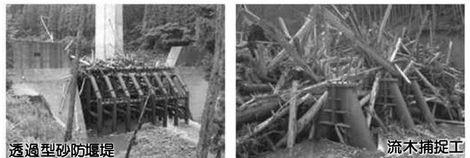
取組事例 透過構造を有する砂防施設
