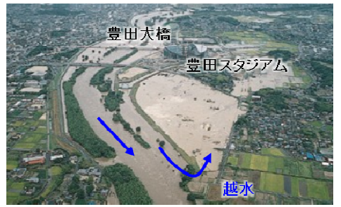
H12年9洪水(豊田市街地付近)
