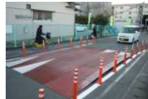
佐賀市北川副地区の可搬型ハンプ試行設置状況
