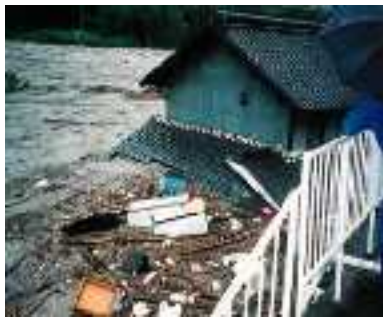
浸水した家屋(豊田市藤沢町)
