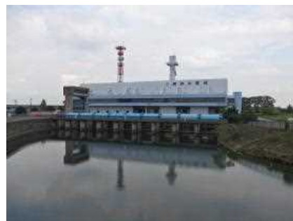
写真 6) みさと放水路
