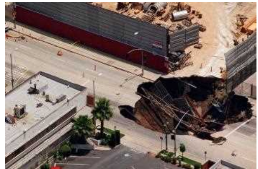
地下鉄建設中に発生した陥没。およそ300,000ガロンの水が土砂とともにトンネル内部に流れ込んだ
