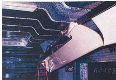
吊り天井の脱落被害の様子
