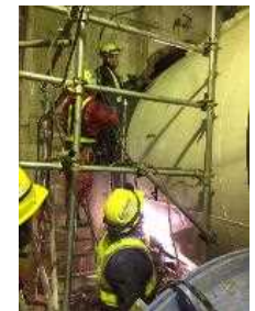
【シールド機で立坑内横穴を塞いでいる状況】
