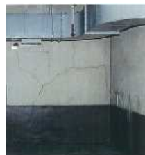
ひび割れ調査
