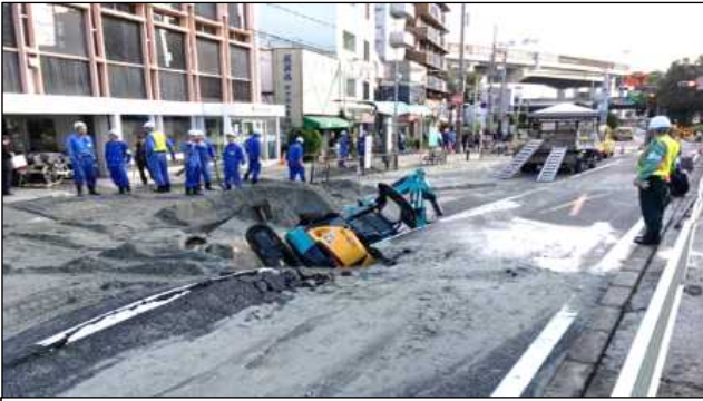
腐食に伴う水道管破裂による路面陥没（長さ10m、幅5m、深さ3.0m）
