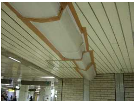
地下通路の漏水の様子
