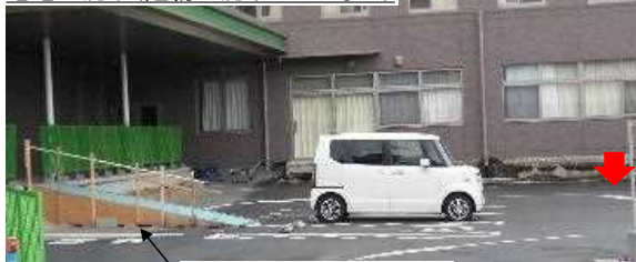
地震後に斜路を応急復旧
