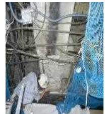
天井点検調査
