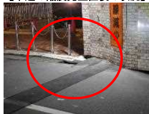
【市道の陥没発生直後の状況】
