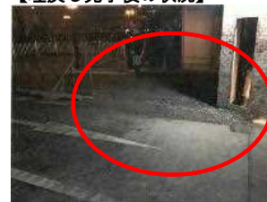
【埋戻し完了後の状況】
