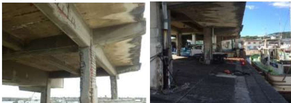
コンクリートが剥離し、鉄筋が露出する漁協施設
