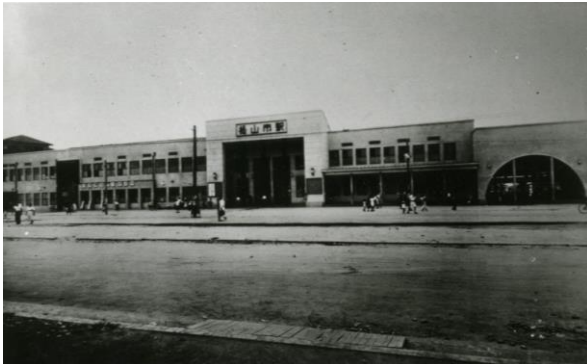
松山市駅と伊予鉄道本社ビル新築工事落成
