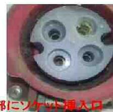
制御盤の下部にソケット挿入口をあけ、プラグ接続
