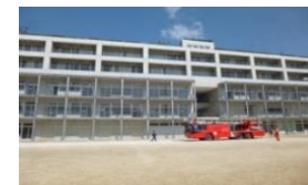
複合施設全体の合同消防訓練
