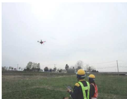
UAVによる施工前の測量
