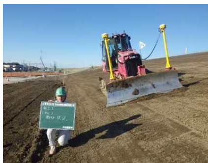
M Cブルドーザ法面整形
