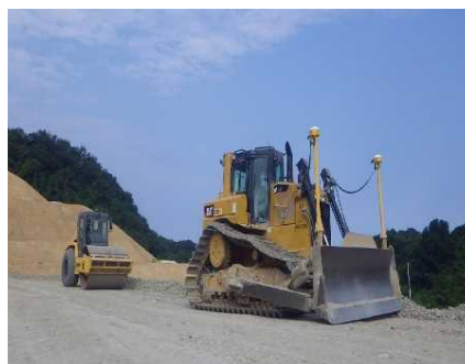
M Cブルドーザ敷均し
