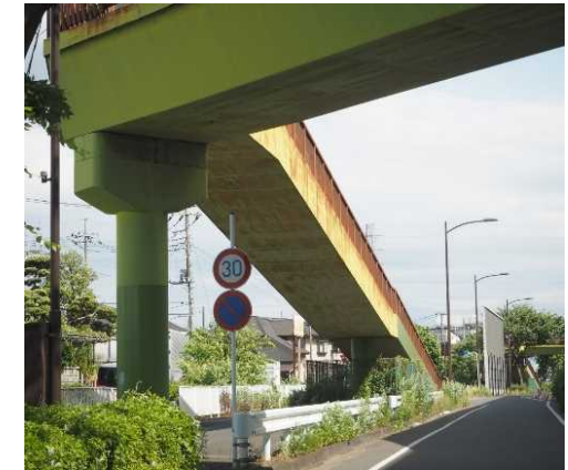
色彩が景観的に目立っている歩道橋
