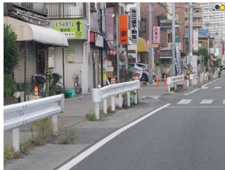
出入り確保のため細切れに設置された車両用防護柵
