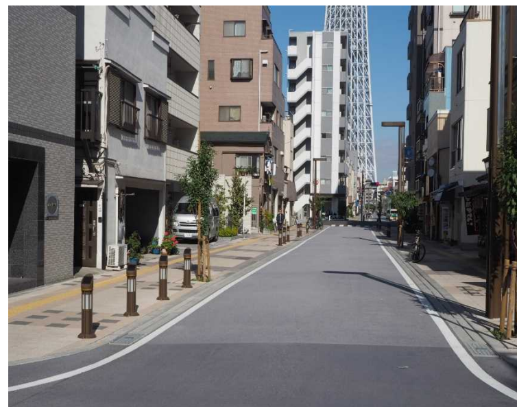
シンプルな形状のボラードを歩車道境界に設置
