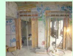
内壁等の補強
