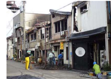
火元建物付近の様子
