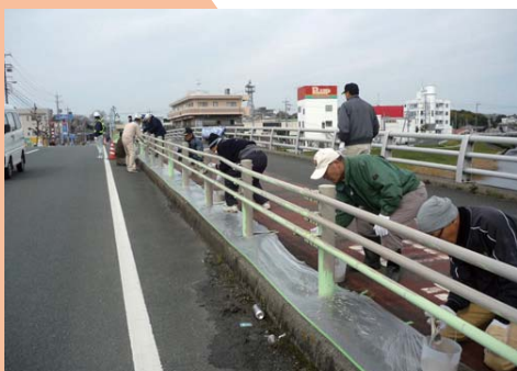
アダプト団体が行うガードパイプ塗装の様子
