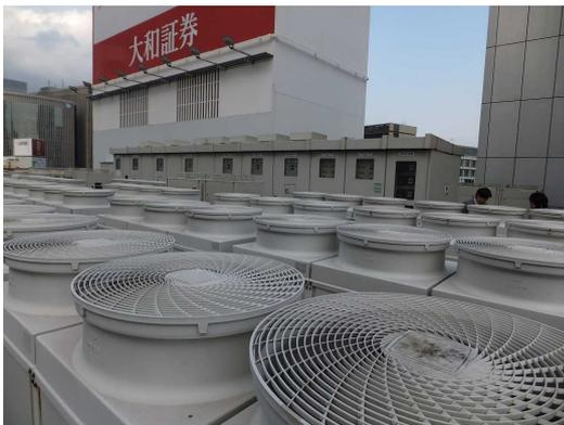
屋上に並ぶ空調機の室外設備と、受変電設備を格納したキュービクル
