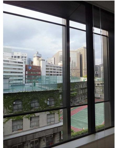
内側の窓枠の高さと比べると、外側の外皮の上部・下部が開口していることがわかる
