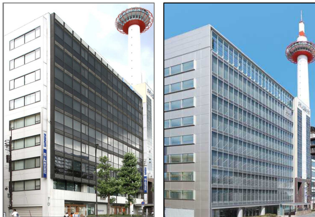
建物外観(左:改修前、右:改修後)
