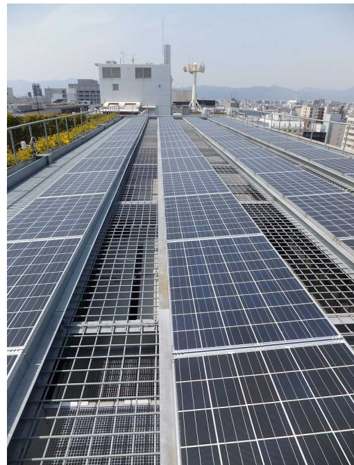
屋上に設置された太陽光パネル
