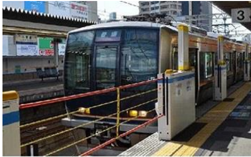
昇降ロープ式ホーム柵
