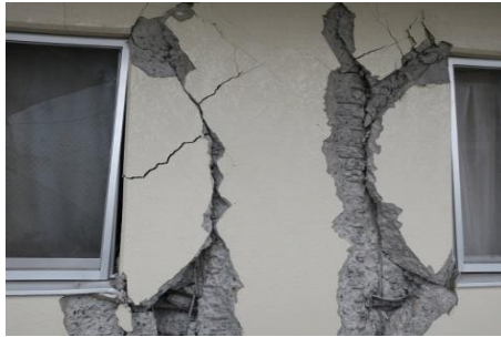
熊本地震における非構造壁の損傷
