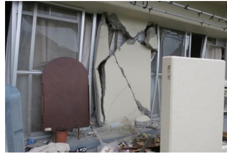
熊本地震における非構造壁の損傷
