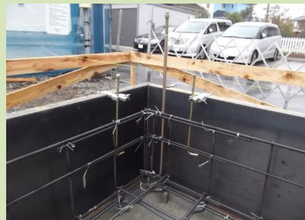
[出隅部分の配筋状況]
