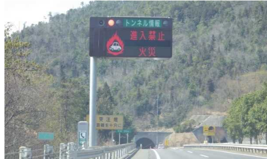
参考写真2 当該トンネル手前の トンネル情報板(火災発生の表示)
