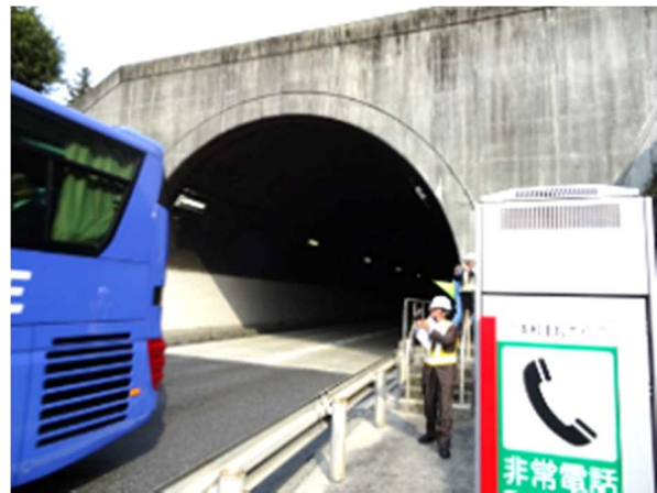
参考写真 26 当該トンネル出口
