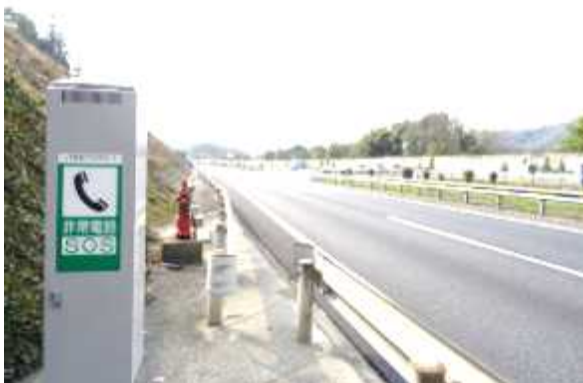
参考写真 27 当該トンネル出口付近
