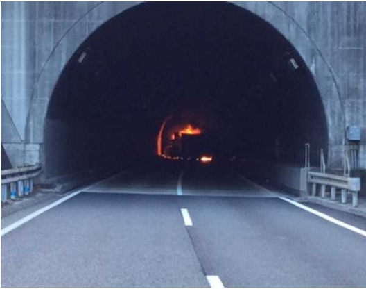
参考写真1 当該トンネル出口から 事故地点
