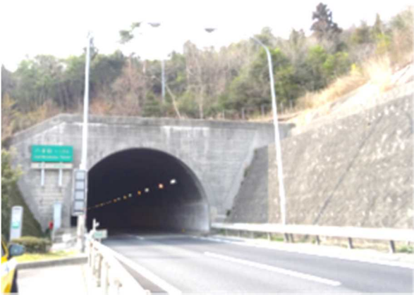
参考写真 23 当該トンネル入口
