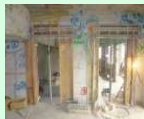
内壁等の補強
