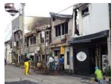
火元建物付近の様子
